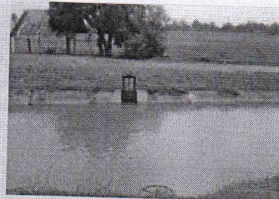
(รูปงานอาคารกระจายน้ำคลองห้วยทราย พร้อมอาคารประกอบ)
